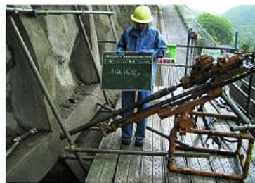
小型ボーリングマシン(空気式)
