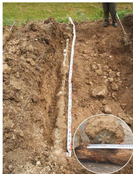
2方向加圧注入後の掘り起し状況
