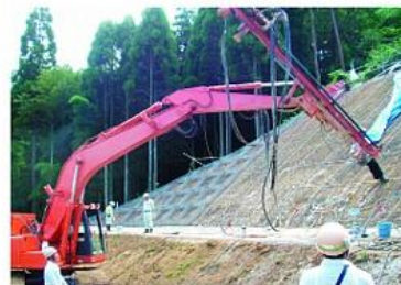
バックホウ式ドリル(空気式) (※更に、SD工法の無足場施工マシンも採用可能)
