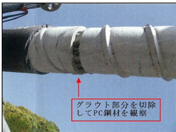
注入試験(凹管)、充填状況とPC鋼材の被り状態
