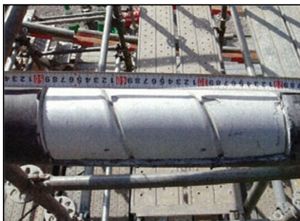
注入試験(凸管)、充填状況(PC鋼材はリブ溝の奥)
