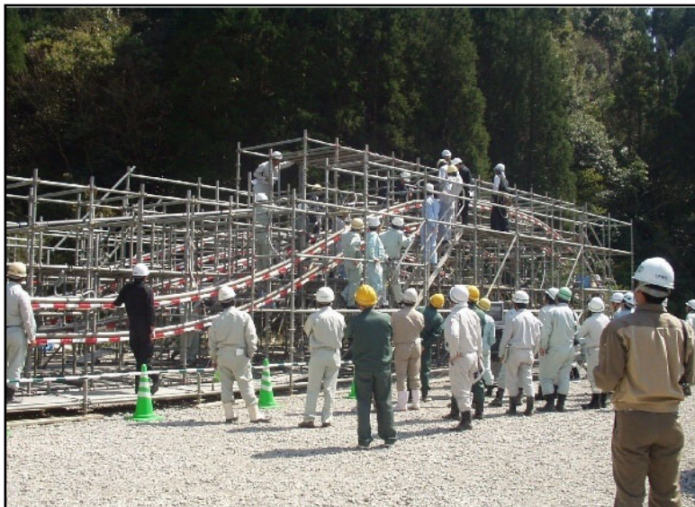
グラウト注入試験
