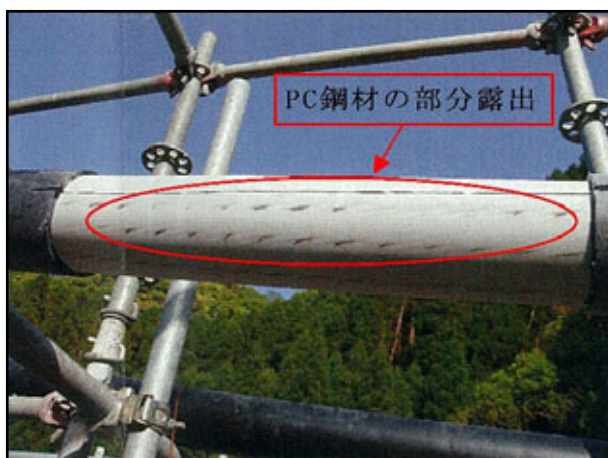
注入試験(汎用管)、充填状況(PC鋼材の被り無し)
