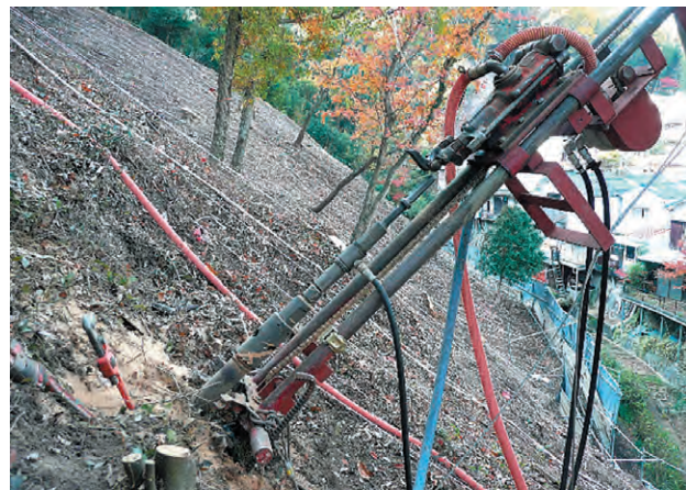
無足場施工マシン（SD-2号機）
