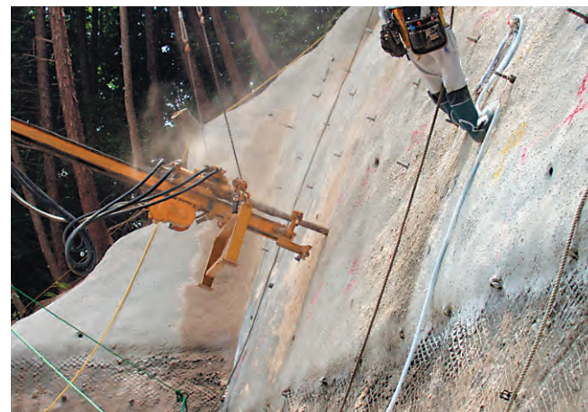
先導ボルト1.50mの打設状況
