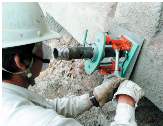
施工状況(人力回収できない時に限定して使用)
