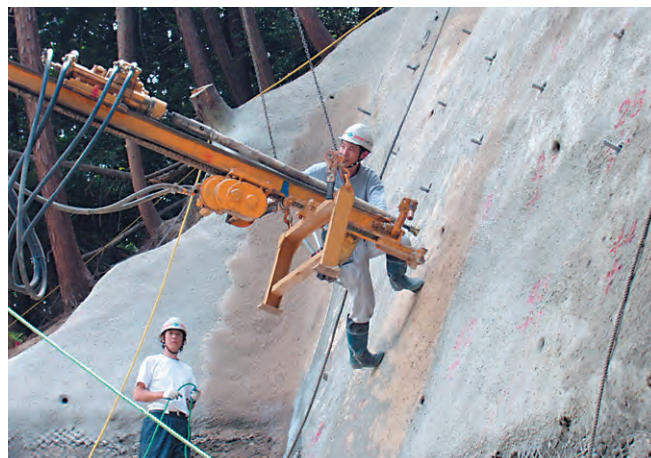
削孔位置と打設角度調整状況
