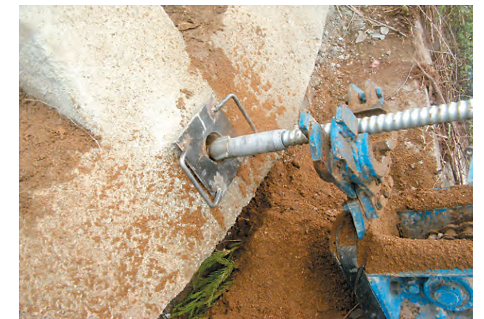
先導管ネジ部のプロテクタ (先導管の沈み防止、余掘りの実現も兼務します)
