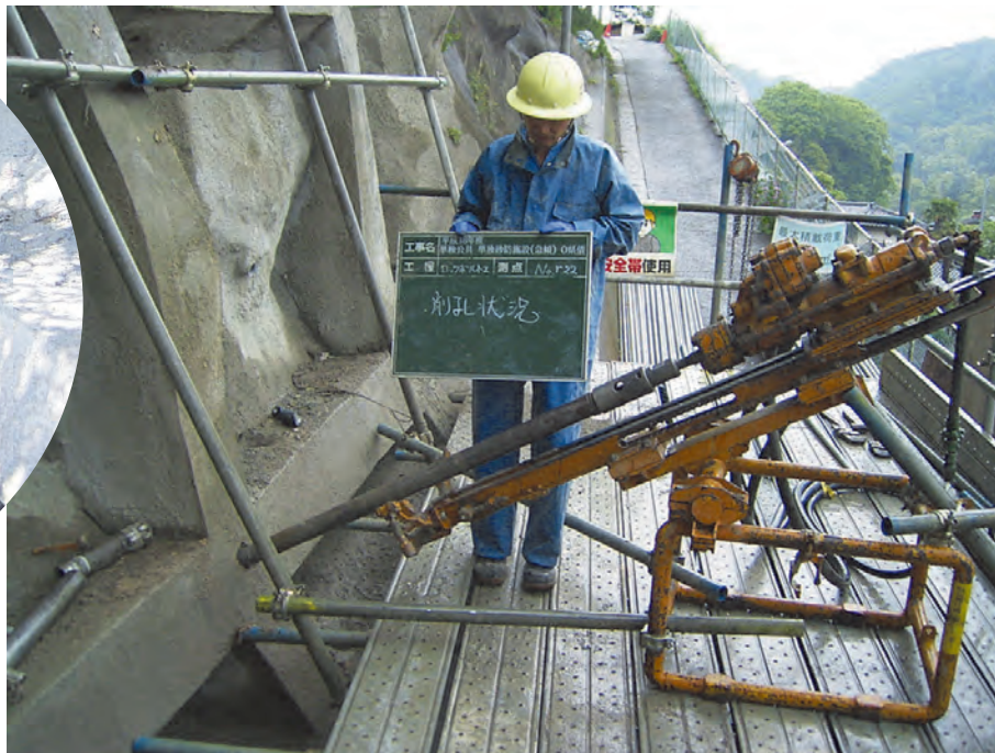
先導管による2重管削孔状況
