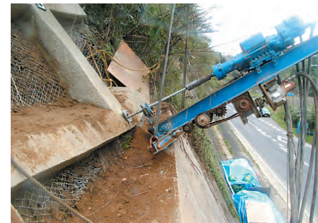
ボルト追打ち削孔状況
