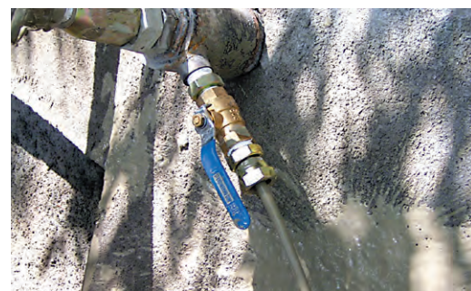
リターン・オーバーフロー確認
