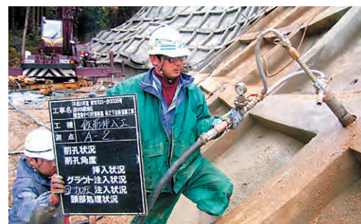
2方向加圧注入の実施
