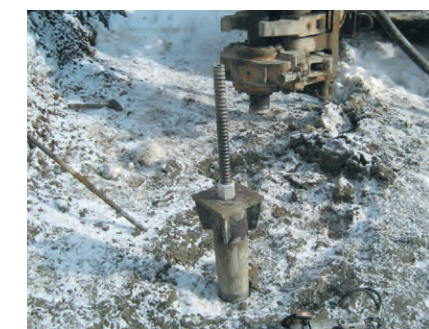
頭部完成状態
