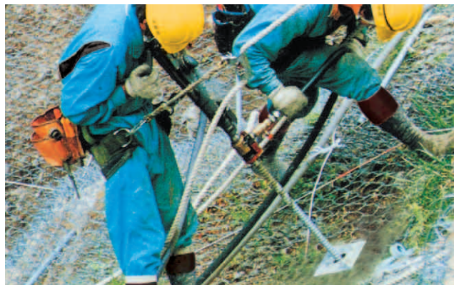
ハンドハンマー削孔状況
