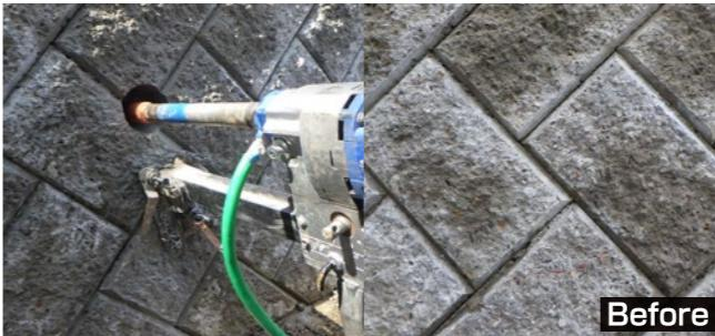
注入アダプターを削孔・注入用ロッドに取り付けてNTRフォームを充填します。削孔・注入用ロッドの中空孔を介して先端開口部より背面地山の空隙部に注入して、オーバーフローさせることで石積壁の裏グリ石層に太径の固化体を形成します。
