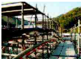
PE管の配置状況
