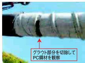
(凹管) PC鋼材の被り状態
