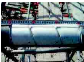
(凸管) PC鋼材はリブの奥
